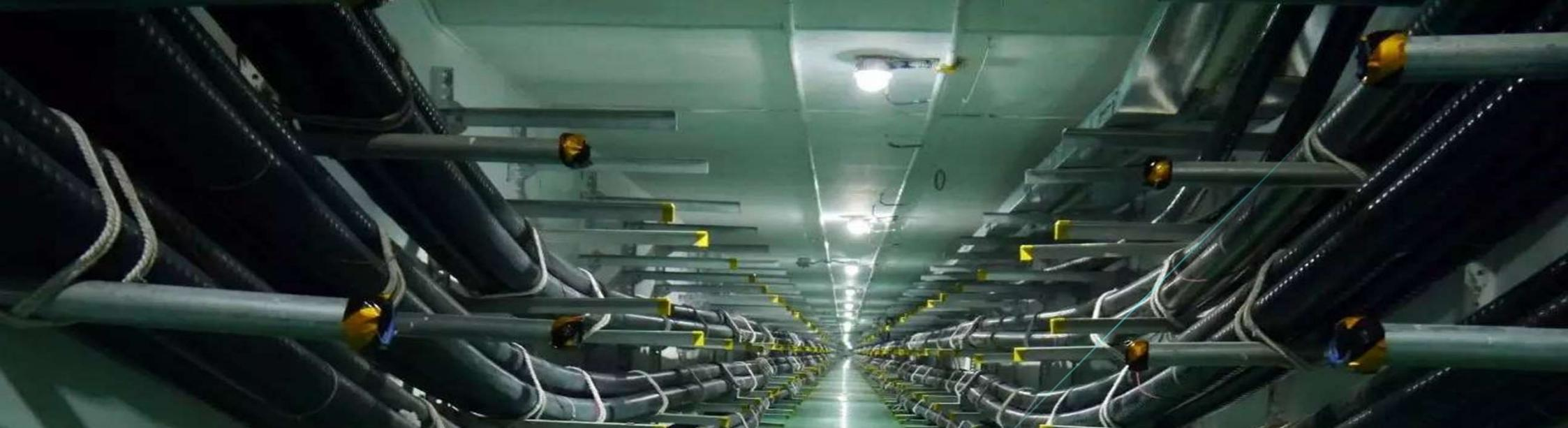
电缆通电时，其工作电流产生的交变磁场将在金属护层上产生感应电势，若护套通过大地形成通路，金属护层上将产生接地环流。但是由于存在线缆盗窃、火灾、绝缘破损等情况，会导致线缆的护层环流异常，甚至护层与大地短路接地，而造成巨大的财产损失并威胁到人身，环流超标时（超过负荷电流的20%或相间最大值/最小值大于3）将产生电缆局部高温损耗发热，加速老化，降低电缆使用寿命，甚至击穿接地等故障，根据Q/GDW512-2010《电力电缆线路运行规程》及DL/T1253-2010中的规定，需要对电缆护层进行接地处理，并定时巡检，一旦发现电缆护层接地环流异常，检修人员需要及时处理，避免损失。
